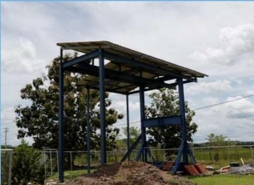
Colocación de Techo a Marco de Prueba del Laboratorio de Suelos y Materiales
